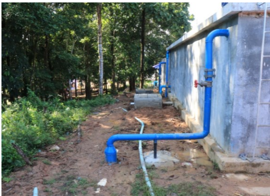
ถึงเก็บน้ำ
