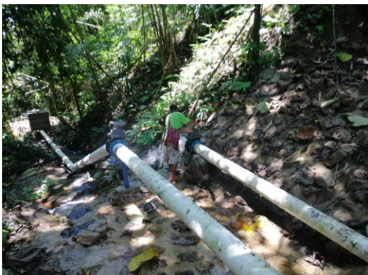
ระบบท่อส่งน้ำ
