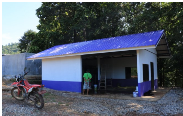
อาคารโรงเก็บเครื่องกรองน้ำ
